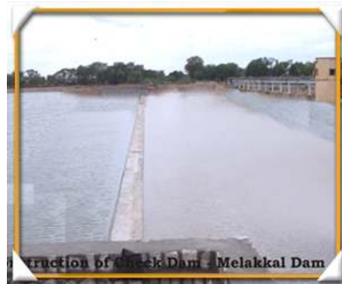
Fig: Check Dam - Melakkal
