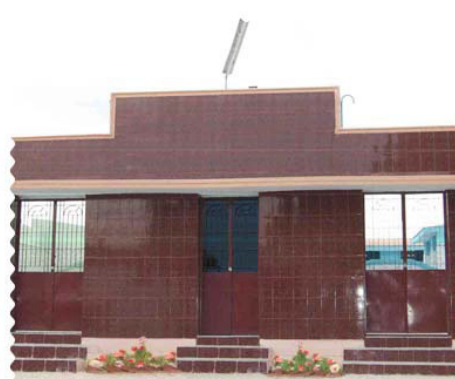
FIG: Mordern Toilet
