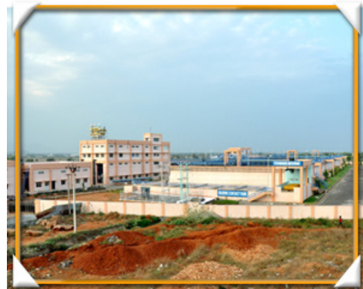
Fig: Sakkimangalam – STP
