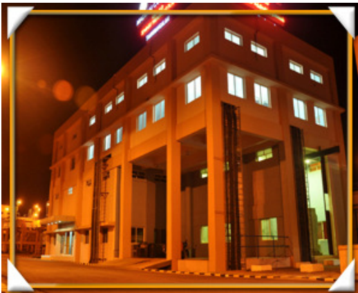
Fig: Sakkimangalam – Admn.office
